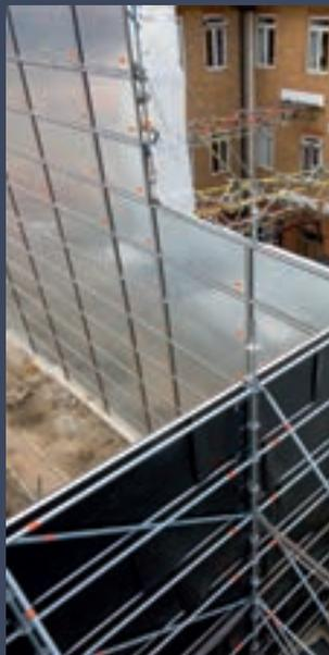
Bei Umbau, Aufstockung, Renovierung und Restaurierung haben sich die anpassungsfähigen Layher Kassettdächer einen festen Platz erworben. Bauwerk und Einrichtungen bleiben während des Umbaus oder der Dachreparatur bestens geschützt, der Geschäftsbetrieb kann gut überdacht weitergehen. Bei kleinen und mittleren Spannweiten eignen sich Layher Kederdächer als überzeugend preiswerte Komplettlösung – leicht und optisch attraktiv.
