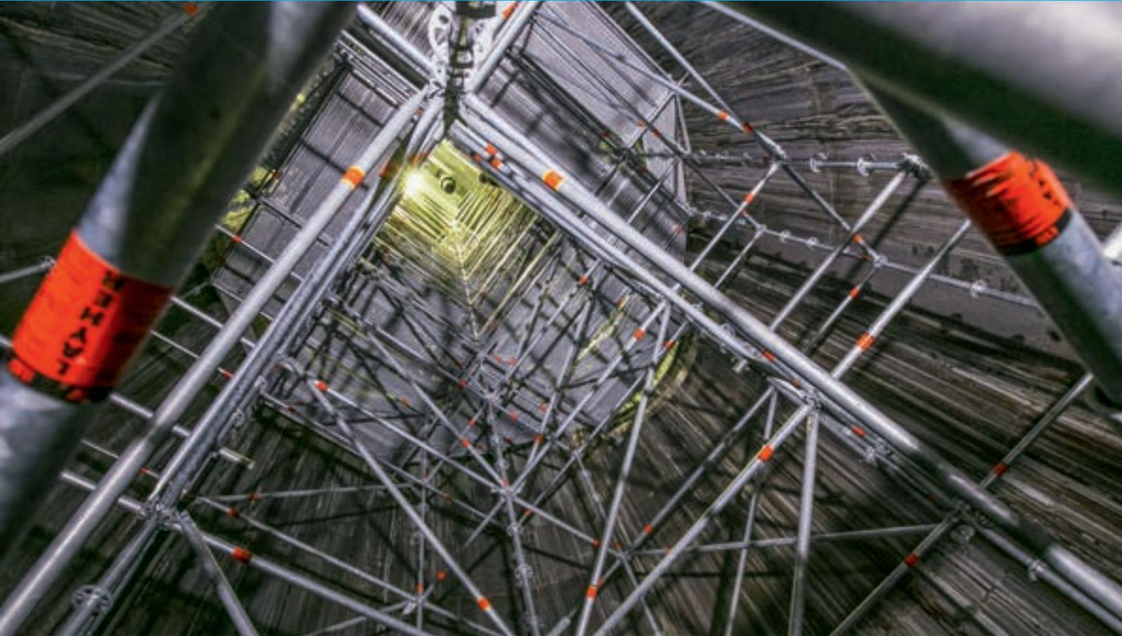
Das Layher AllroundGerüst hat 1974 mit seiner bewährten Keilbindungstechnik den Gerüstbau revolutioniert. Das Original bietet überzeugende Einsatzvielfalt, insbesondere bei schwierigsten Geometrien und Verankerungs-Voraussetzungen. Ob als Arbeits-, Schutz- oder Stützgerüst, als Innen-, Fahr- und Deckengerüst: Es gibt nichts, was Sie mit dem Layher Allround-System nicht schnell, kostengünstig und sicher lösen.
