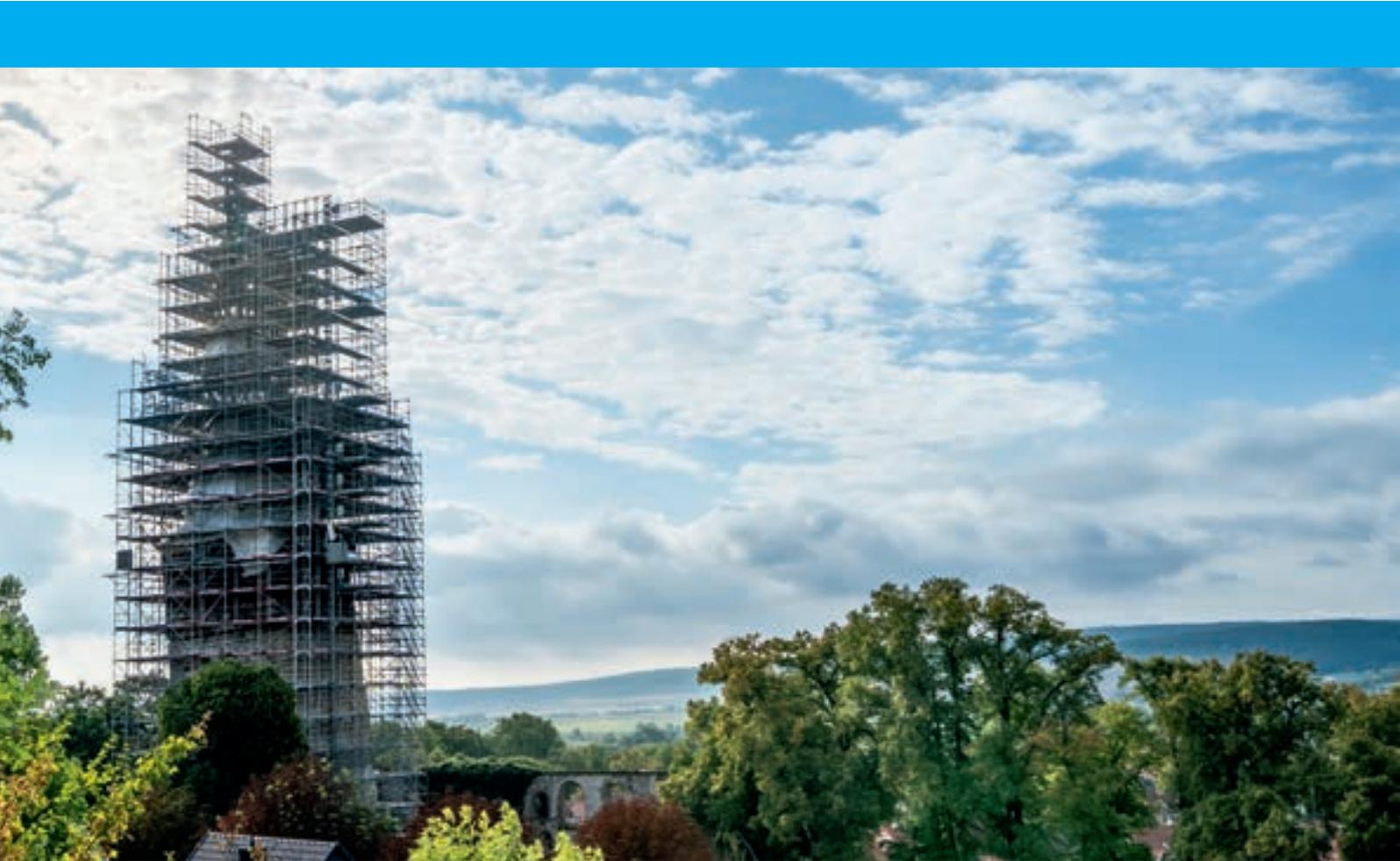
Mit nur sechs Grundelementen und wenigen Handgriffen schafft der Layher Klassiker „blitzschnell“ sicheren Stand für alle Arbeiten. Seit seiner Einführung 1965 ist es das maßgebende Steckrahmengerüst auf dem Markt. Einfach schnell, robust und stabil, ideal für den Einsatz an Fassaden. Das Layher Blitz Gerüst ist durch sein vielseitiges Teileangebot für den Gerüstbau wie für das Bauhandwerk gleichermaßen rentabel einsetzbar.
