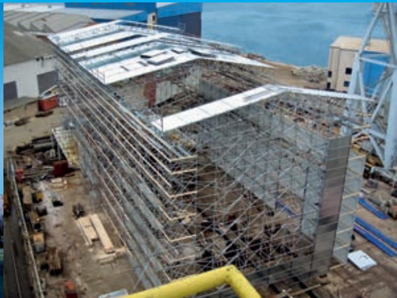
Das Layher Protect-System wird den hohen Anforderungen an zeitgemäßen Umwelt-, Lärm-, Wetter- und Passantenschutz optimal gerecht – und das auf optisch ansprechende Weise. Seine staubdichte Ausführung macht es zur ersten Wahl bei Asbestsanierungen, Fassadenbekleidungen und Sandstrahlarbeiten. Dank guter Lärmdämmeigenschaften eignet sich das System auch bestens für temporäre Lärmschutzwände, zum Beispiel bei Baustellen im innerstädtischen Bereich oder bei Großveranstaltungen.
